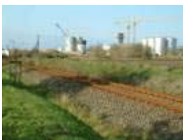
Aufbau einer Bioethanol-Anlage im Raum Bitterfeld, Firma Sauter
